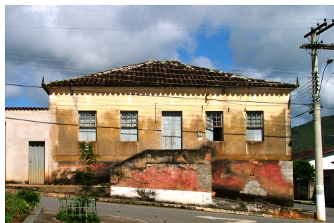
Imagem 8: Casa de Miguel Machado
